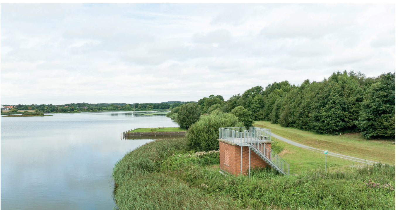
Foto: Sehen - Det gamle pumpehus og platformen
